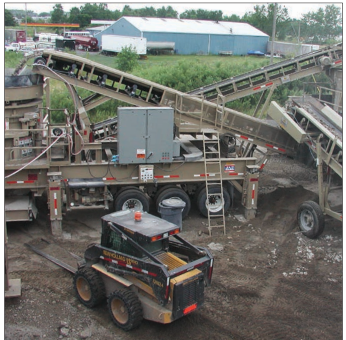
La planta trituradora portátil es movida frecuentemente, por lo que la velocidad y facilidad para hacer las conexiones de energía son importantes.
