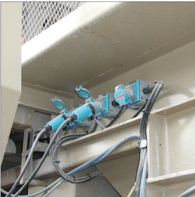
Este acercamiento muestra múltiples conexiones MELTRIC que facilitan el movimiento de los componentes portátiles de la planta.
