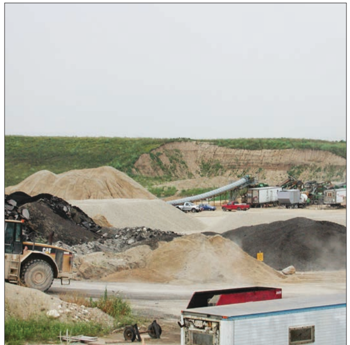
Las trituradoras portátiles y bandas transportadoras en esta operación de agregados de Payne & Dolan son fáciles de mover mientras siguen la fuente del material, porque los tomacorrientes MELTRIC simplifican las conexiones de energía
